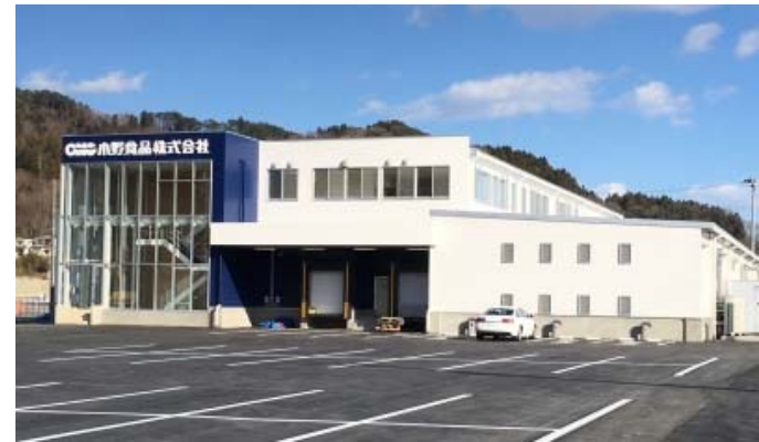
再建された新大槌工場(2016/3)
